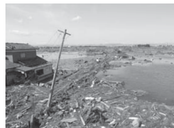
東日本大震災による被害 (宮城県仙台市)
